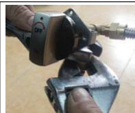
Déposer le tuyau de propane
