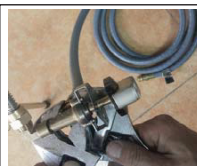
Installer le tuyau de gaz
